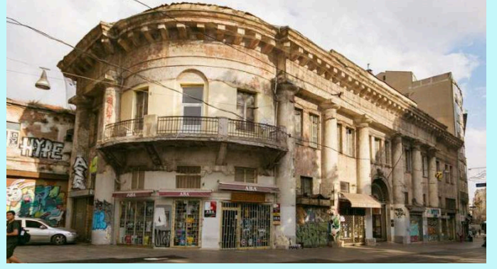
Narmanlı Han'ın, 2016'da başlayan restorasyon çalışmaları öncesindeki durumu
